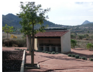
ÁREA RECREATIVA EL COLORADO Àrea Recreativa “El Colorado” “El Colorado” Recreational Area
